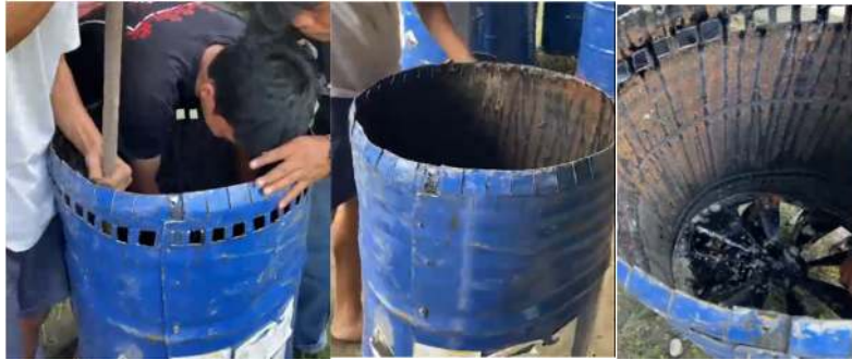
Gambar 5 . Pembuatan ventilasi bagian atas drum di bagian dalam
