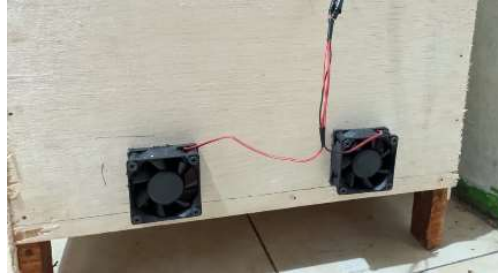
Gambar 7. Menjelaskan pemasangan kipas dc 12v
