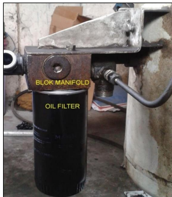
Gambar 8. Pemasangan filter pada filter kompresor.
