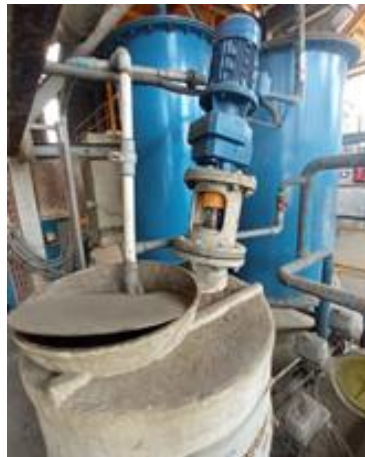
Gambar 10. Mesin pengaduk terpasang
