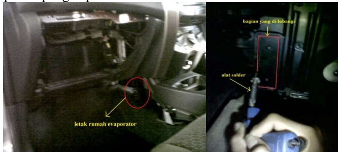
Gambar 6. Letak posisi rumah evaporator yang akan dilubangi
